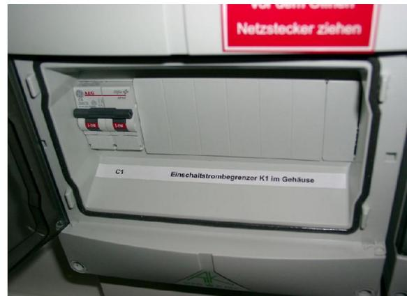
Der Sicherungsautomat C2 sichert die Ausgangsseite des Trenntrafo mit 6A ab.
