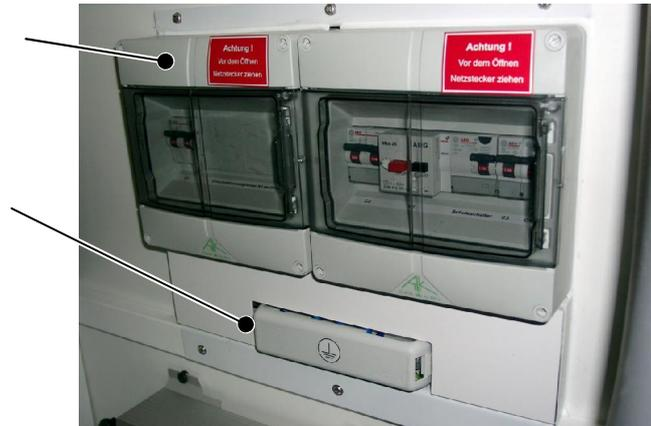
Der Sicherungsautomat C1 sichert die Eingangsseite des Trenntrafos mit 6A ab.
