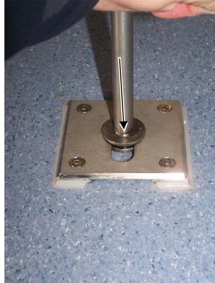
Dann den Stützfuß nach hinten ziehen, so dass dieser durch die beiden Teller am Stützfuß im schmalen Teil der Bodenverriegelung fixiert wird.
