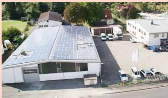
Die neue Photovoltaik-Anlage liefert seit Ende August Sonnenenergie.
