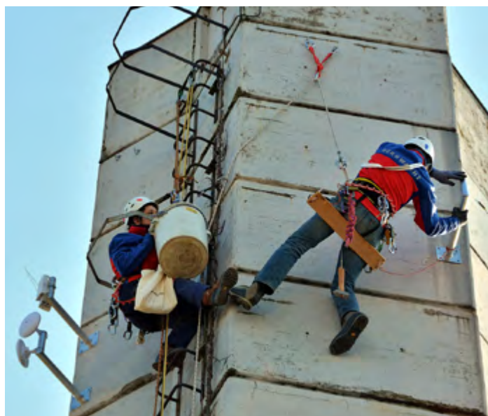
DRK-Bergwacht Heppenheim hilft bei der Installation von Richtfunkantennen in 25 Metern Höhe.
